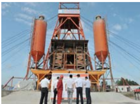
滕家回风井井筒掘砌工程施工现场
