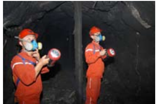
安全管理人员深入到回风井检查局部通风情况
