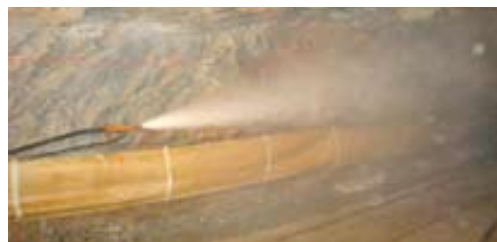
玲珑金矿井下掘进迎头风水联动除尘装置
